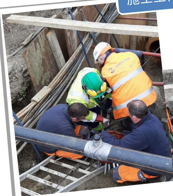
图左|起点坑 图右|终点坑
